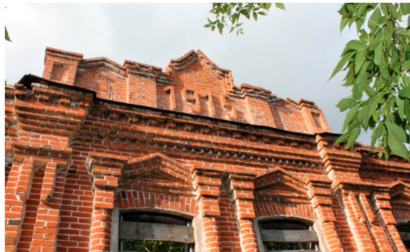
Рис. 5 Фрагмент бывшего дома купца Боярского с датой постройки на аттике: 1915 г. Фото С.В. Киселевой, 2025 г.
